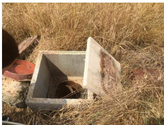
Arqueta de protección del sondeo
