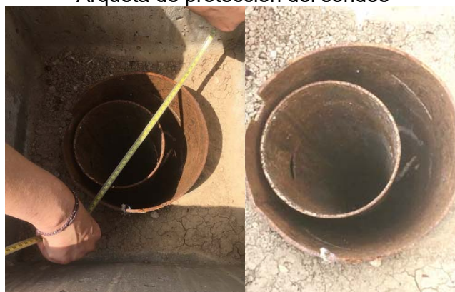
Detalle del brocal del pozo
